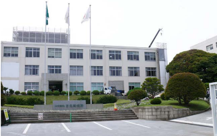
耐震補強工事がほぼ完成した日立事業所本館(三階建)
